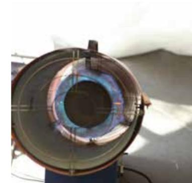
A l'aide d'un canon à chaleur, la toile tendue est chauffée à une température de 40° à 60° en partie haute de la pièce afin de le positionner sur ses supports.
