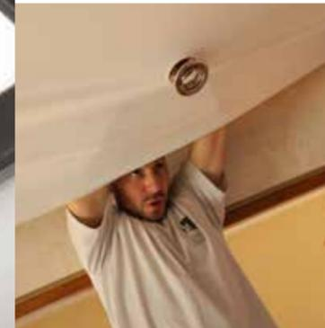
Les luminaires sont fixés directement au plafond sur des supports (chaise) et intégrés à la toile par des réservations faites à l'endroit que vous souhaitez.
